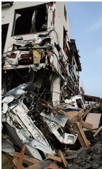
町が大津波により壊滅的な被害
